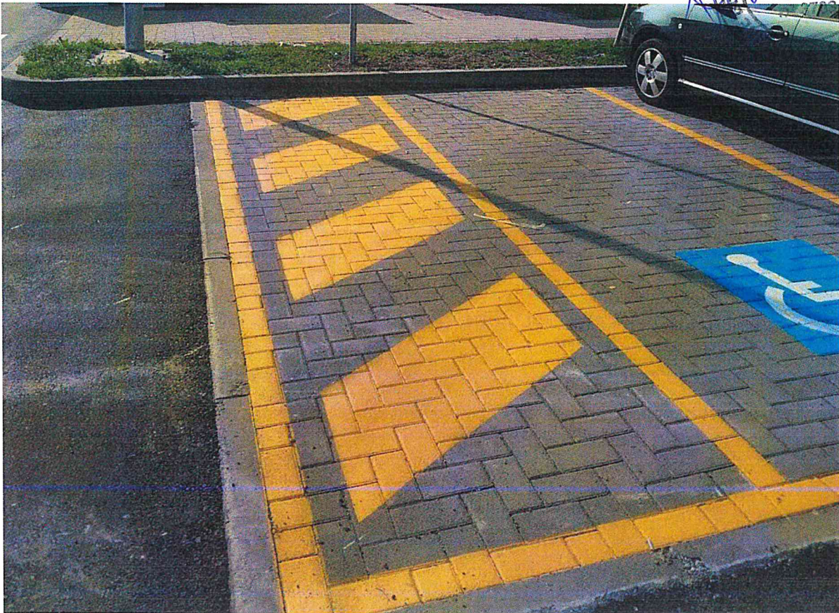
Segnaletica orizzontale – posto auto disabili
