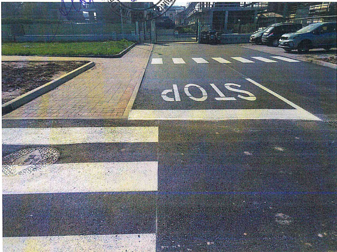
Passaggi stradali verso aree private - marciapiede
