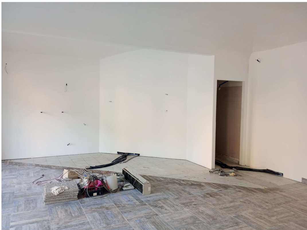
vista locale bar (a destra l'ingresso della cucina)
