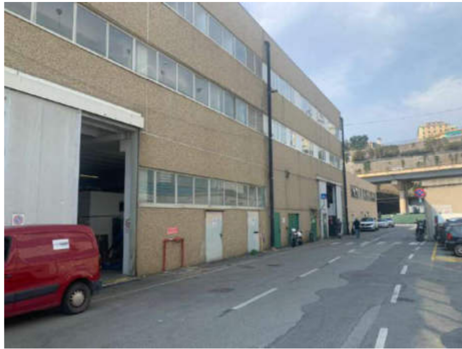
2 - vista del compendio demaniale da Via Duca di Galliera
