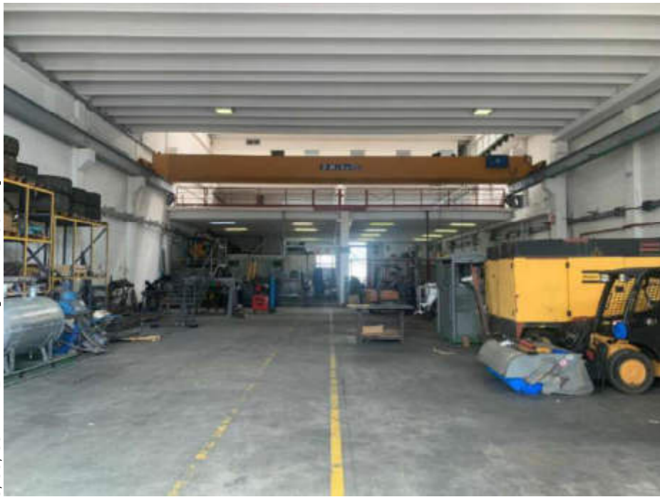
19 - porzione Ovest piano terra unita' 12
