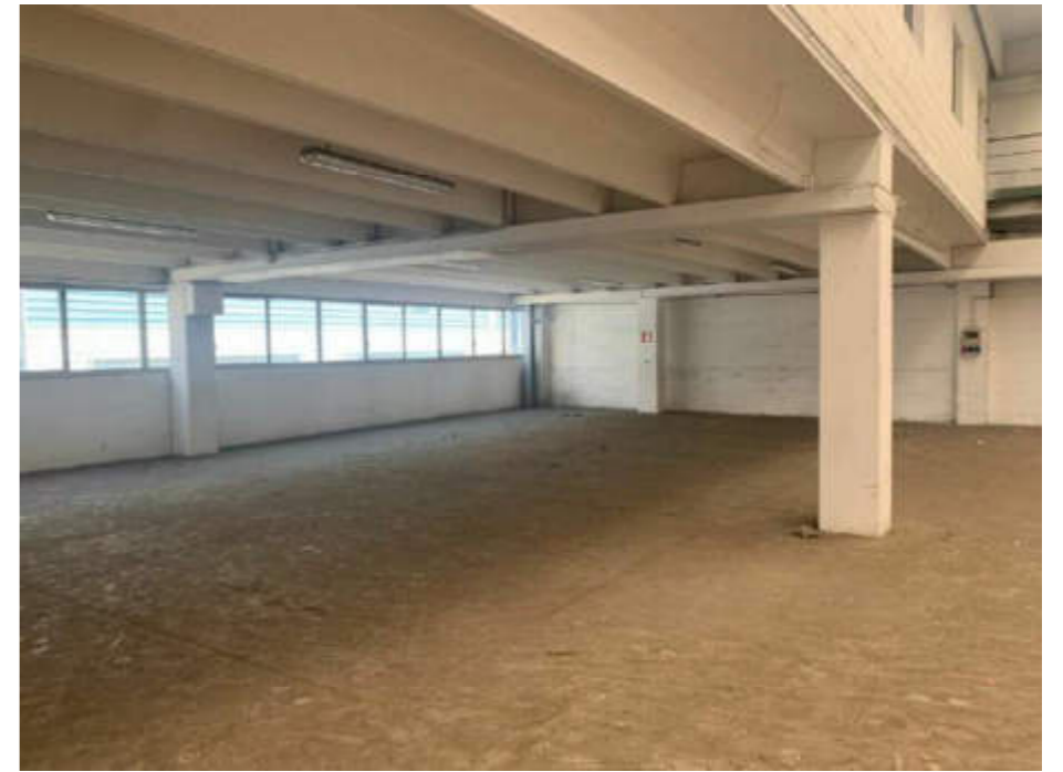
21 - soppalco piano primo unita' 12
