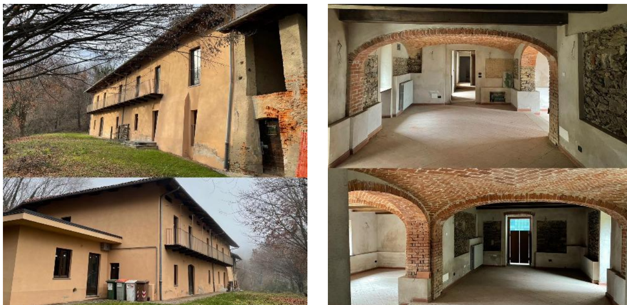
Figura 2: Esterno e interno di Villa Aliberti
