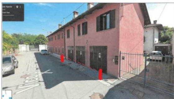
Vista zona di posa con segnaletica paletti
