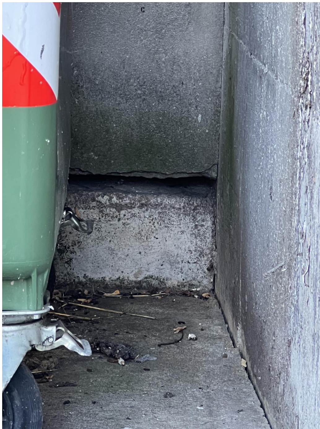
Fig. 3 Particolare cordolo appoggio muri
